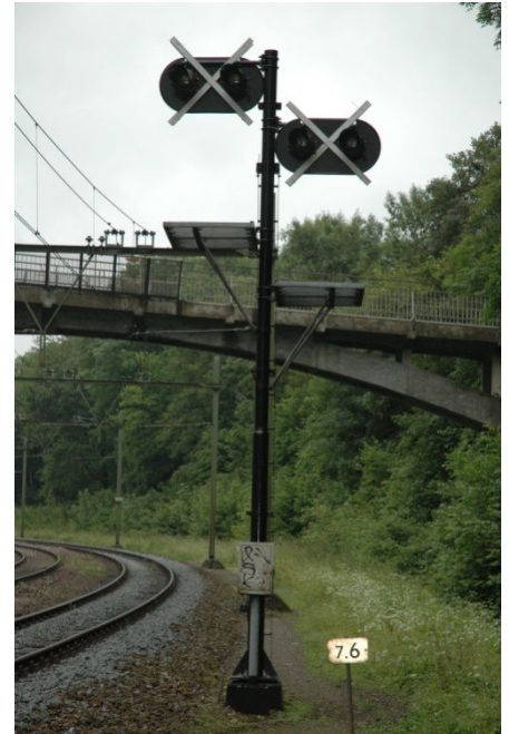
Het WUBO sein langs de spoorlijn Maastricht-Heerlen, in de boog bij Schin op Geul. Hoewel buiten werking gesteld nog prima als voorbeeld voor de modelbouw.
