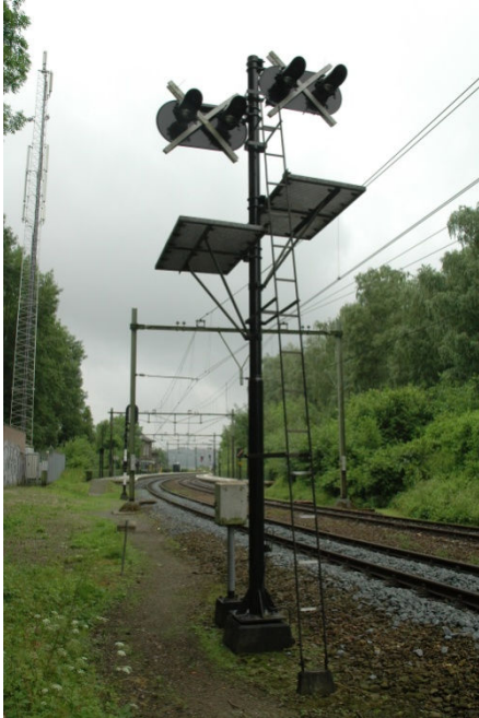
Het WUBO sein vanaf de ladderzijde gezien. Ook de constructie van de bordessen is goed zichtbaar.
